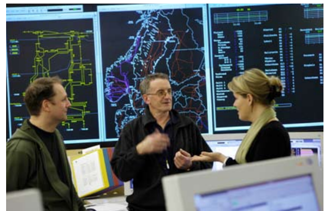
Grid control centre at Svenska Kraftnät, Stockholm.
